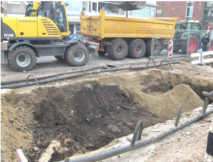
Afb. 3.3 De ontgraving ten behoeve van de afvalcontainers met links op de voorgrond muur S1009.
